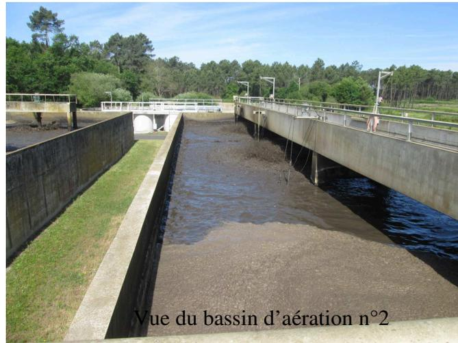
Il n'est pas observé de remontées de boues dans le clarificateur. Les mesures effectuées dans l'ouvrage ne sont pas bonnes en raison de l'accumulation de boues dans les ouvrages.
