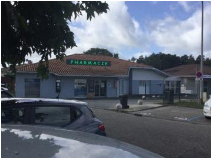
Enseigne sur toiture avec un panneau de fond (infraction), Mios, Octobre 2019
