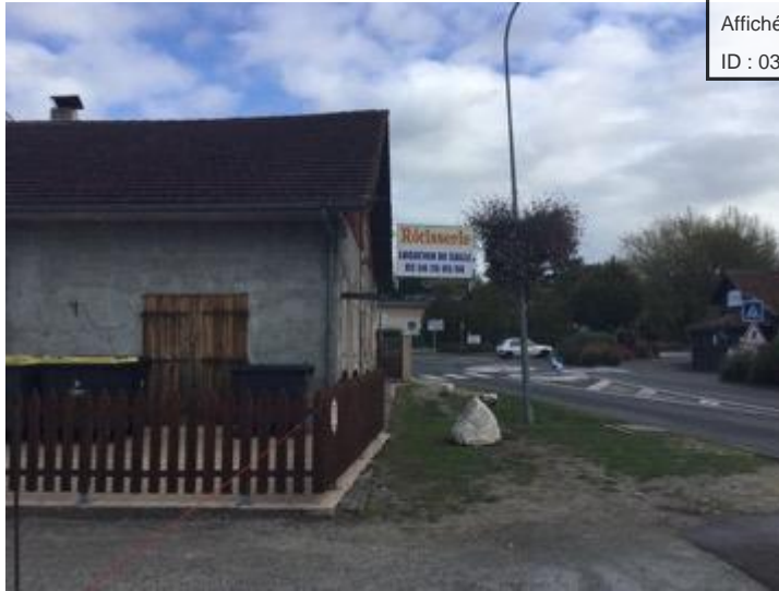
Enseigne perpendiculaire au mur, Mios, Octobre 2019
