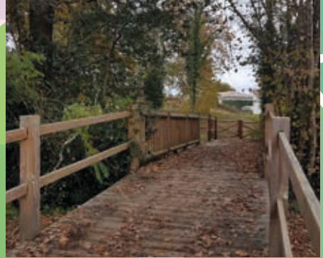
PASSERELLE SUR L'ANDRON
