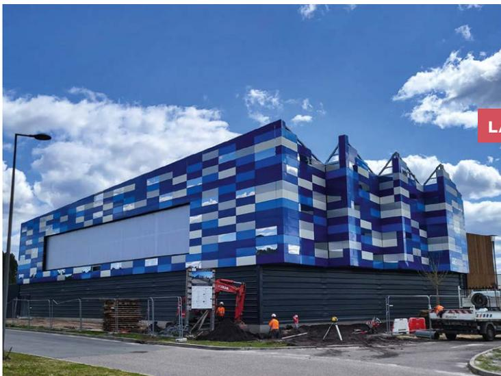
Les travaux intérieurs se poursuivent avec notamment la pose du carrelage. Quant à l'extérieur le bardage coloré et le bardage bois ont recouvert les façades.
